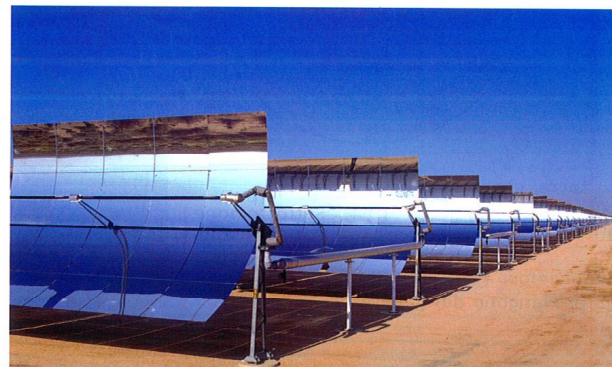
Una centrale solare termodinamica.
