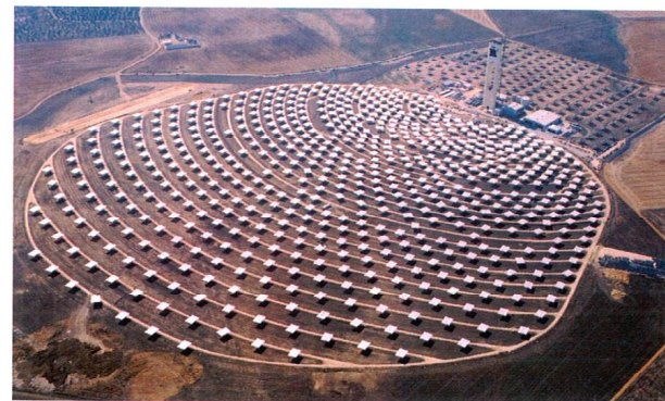
Una centrale solare a concentrazione.
